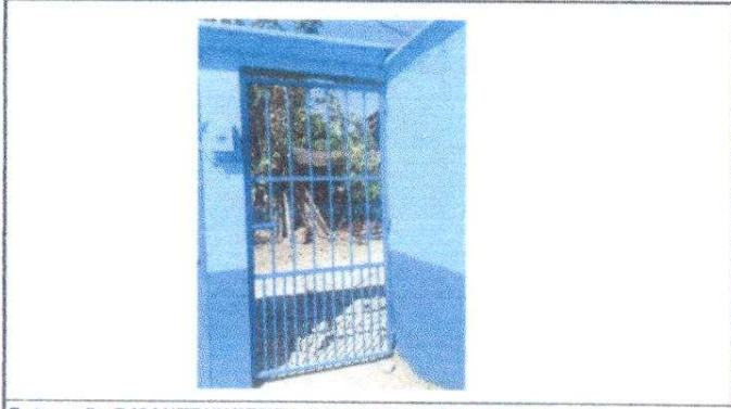
Fotografía 7 MANTENIMIENTO DE PORTON EN ENTRADA DEL ESTABLECIMIENTO.
