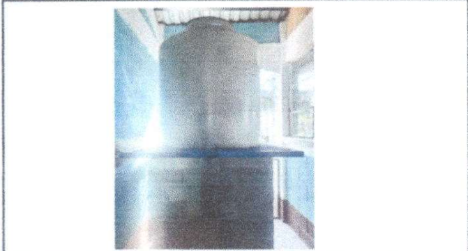
Fotografía 11 INSTALACIÓN DE ESTRUCTURA PORTANTE DE METAL PARA SOPORTE DEL DEPOSITO DE AGUA.
