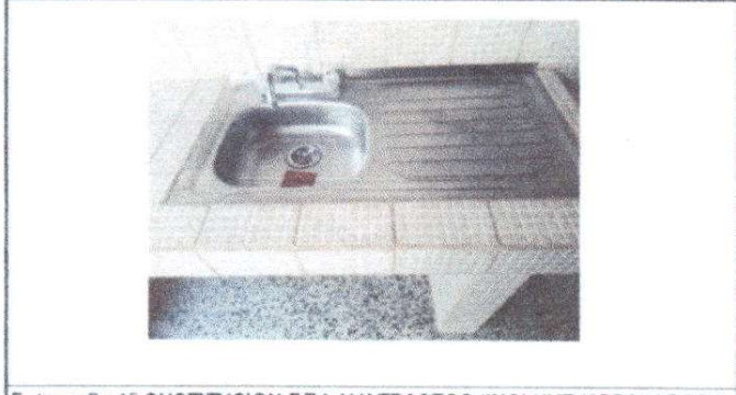
Fotografía 15 SUSTITUCION DE LAVATRASTOS (INCLUYE MEZCLADORA) EN ÁREA DE COCINA.
