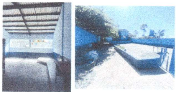
Fotografía 5: PINTURA DE MUROS EXTERIORES E INTERIORES EN TODO EL ESTABLECIMIENTO.
