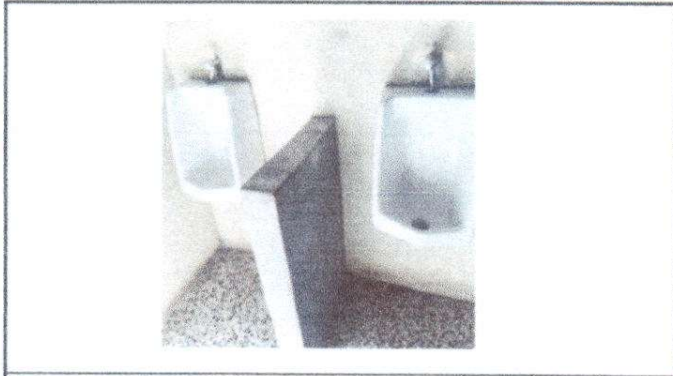
Fotografía 7 SUSTITUCION DE LLAVE DE MINGITORIO EN BAÑOS DE HOMBRES
