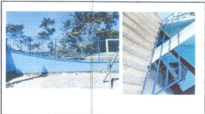
Fotografía 8 MANTENIMIENTO DE BARANDA DE METAL EN MUROS EXTERIORES DEL ESTABLECIMIENTO.
