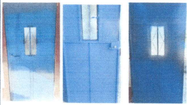
Fotografía 1 MANTENIMIENTO A ESTRUCTURA (LIJADO, CAMBIO DE TUBO, CEPILLADO, SUJECIONES, APLICACIÓN DE PINTURA EN PUERTAS DE TODO EL ESTABLECIMIENTO)
