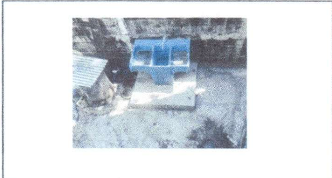
Fotografía 13 SUSTITUCIÓN DE PILA DE CEMENTO DE DOS LAVADEROS
