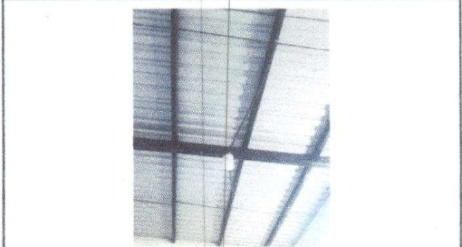
Fotografía 12 INSTALACIÓN DE UNIDADES DE LUZ (INCLUYE INTERRUPTOR, DUCTO Y CABLE ELÉCTRICO EN TODO EL ESTABLECIMIENTO)
