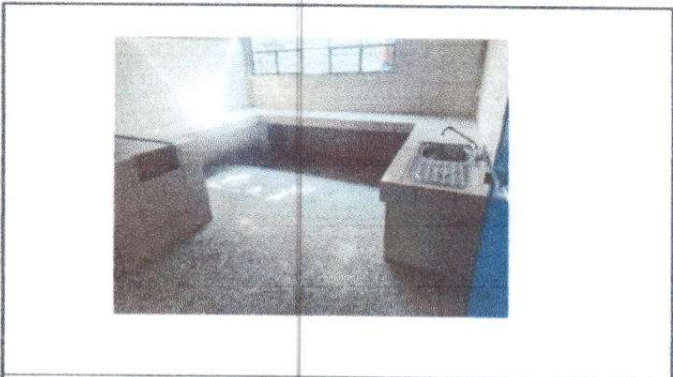
Fotografía 8 COLOCACION DE AZULEJO EN ÁREA DE COCINA.
