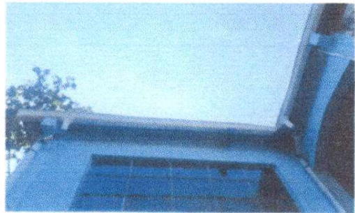
Fotografía 3 SUSTITUCION DE CANAL DE PVC EN TODO EL ESTABLECIMIENTO.
